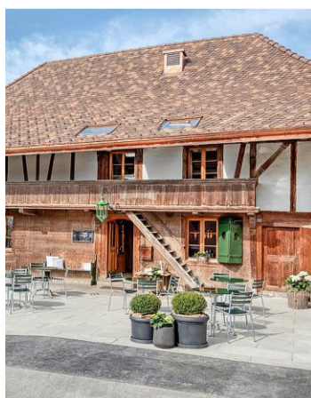
Das Löchlibad wurde vor zwei Jahren umfassend saniert. Foto: PD
